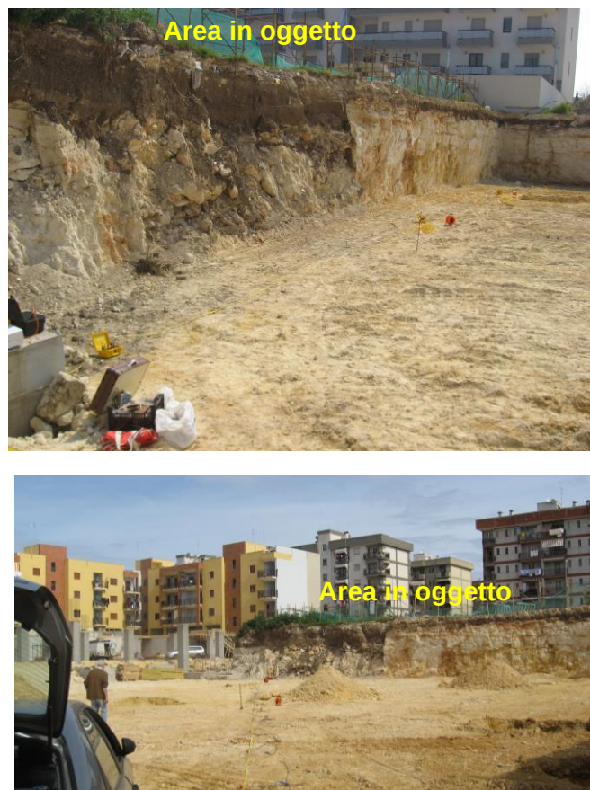
Fig. 19 – Fronte di scavo lungo il confine meridionale
