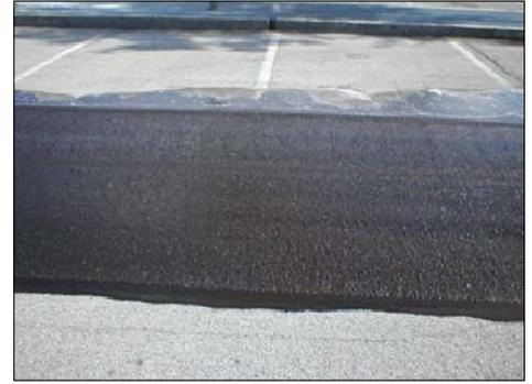
Posa in opera e lavorazione di un manto stradale a doppio involucro (asfalto a bassa rumorosità)
