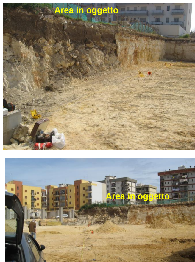
Fig. 23 – Fronte di scavo lungo il confine meridionale
