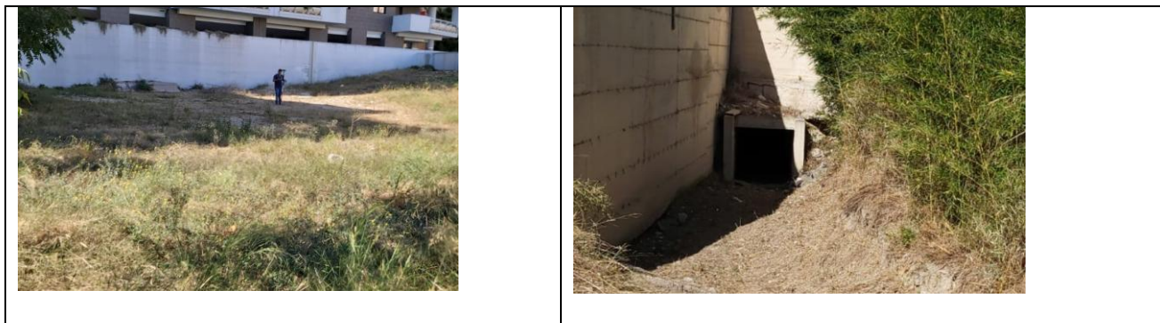
Tombino di imbocco canale a contorno chiuso cittadino
