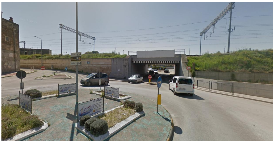
Sottopasso di Via Ruvo
