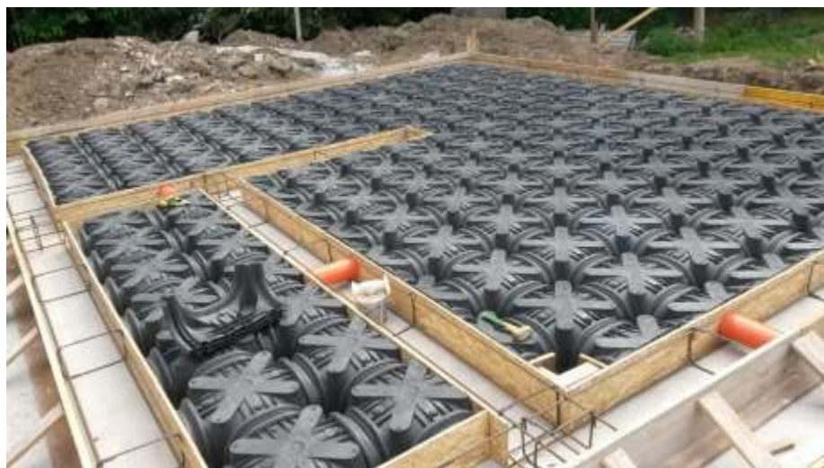
Fig. 33 – a) Schema e b) foto reale di vespaio con iglù
