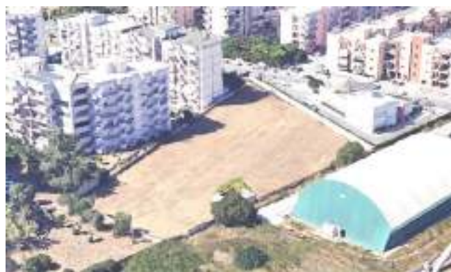
Figura 10: blocco 1/A visto da Sud-Est
