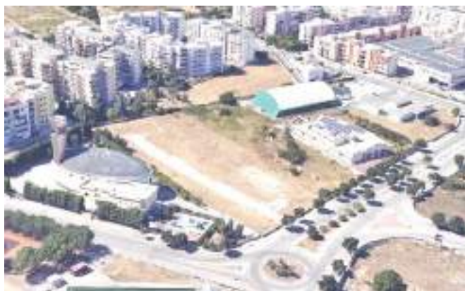
Figura 12: blocco 2 visto da Sud-Est
