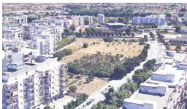
Figura 8: blocco 1/B-1/C visti da Nord
