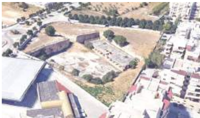
Figura 5: blocco BL visto da Sud-Est
