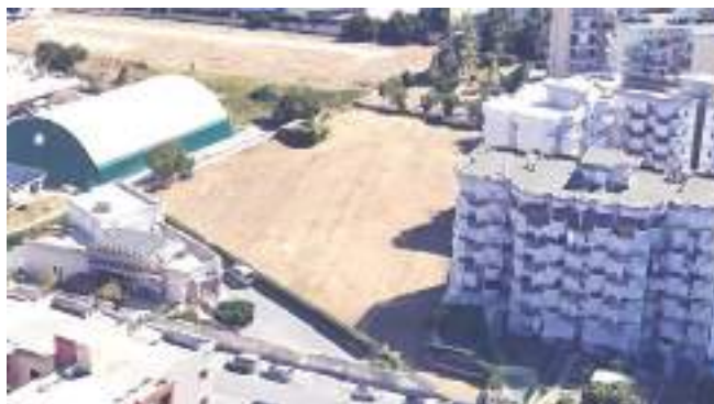
Figura __: blocco 1/A visto da Nord
