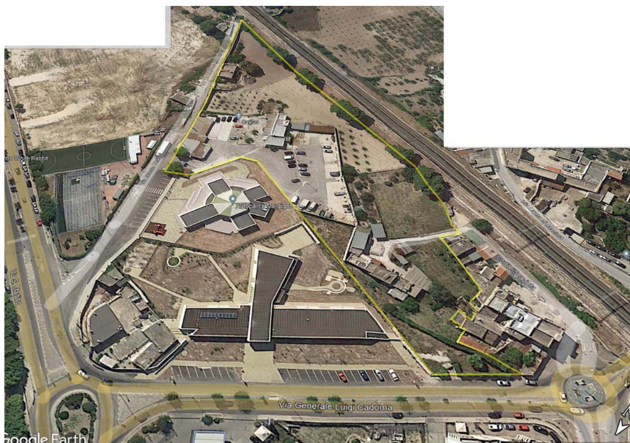
Vista aerea dal lato di viale Cadorna
